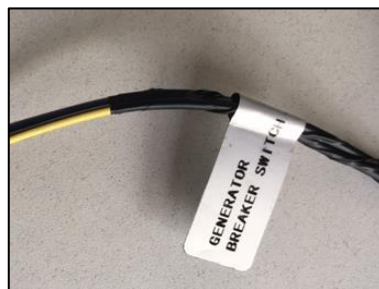
Рис. 3.10.2Д Провод “generator breaker”
